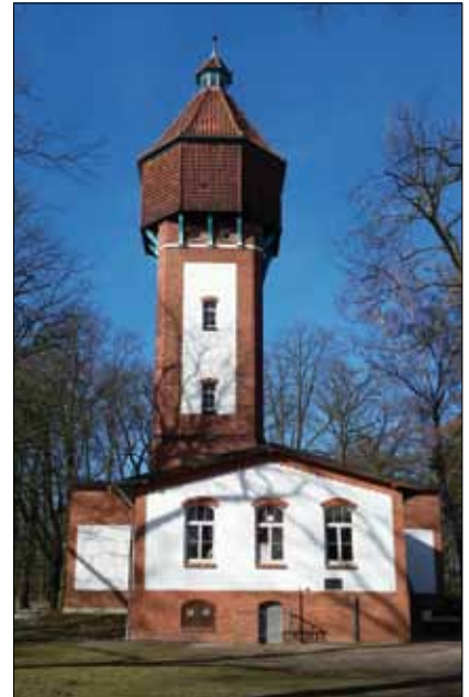
Der Wasserturm in Langenhagen
